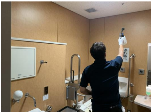
トイレ天井・壁
